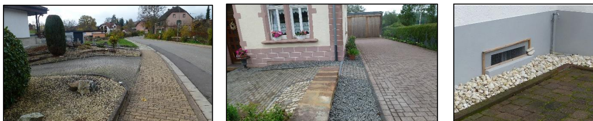
Abbildung 16: Beispiele von Objektschutzmaßnahmen (Überbogen, Geländemodellierungen, Aufkantung am Kellerfenster)
