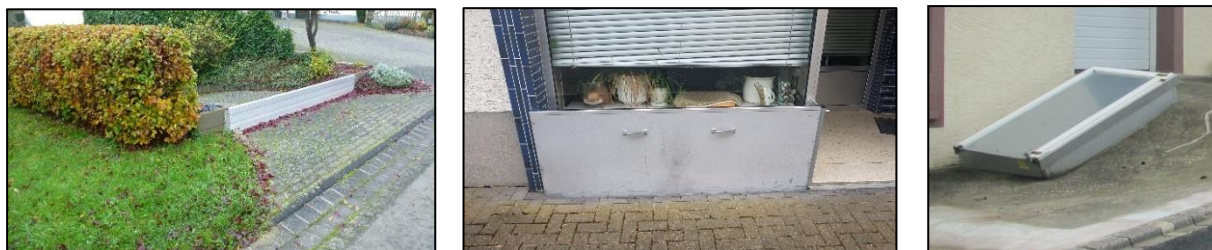
Abbildung 15: Beispiele von Objektschutzmaßnahmen (mobile Steckelemente, Dammbalkensysteme, Abdichtungen)
